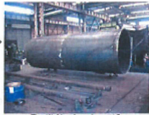
② 巻管ドッキング
